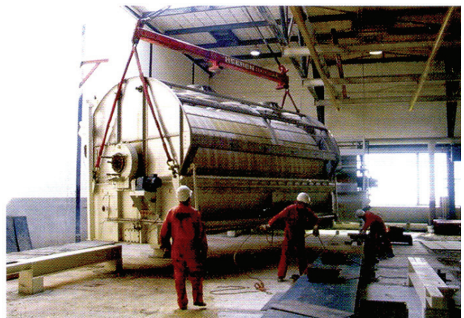
شکل ۸: ساخت فیلتر خلاء در دینترلورد
