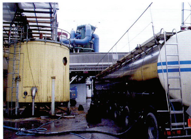
شکل ۳: مخزن کربنات کلسیم رسوب شده (گل صافی) در کارخانه Örtofta
