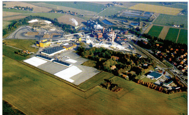
شکل ۱۰: کارخانه Kopingebro از شرکت دانسیکو
