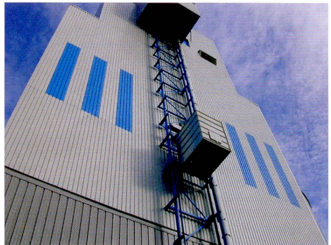
شکل ۱۵: تاسیسات ذغال سازی اسکپ
