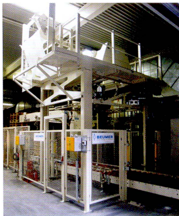
شکل ۱۷: نصب دستگاه روکشی در پلاتینگ
