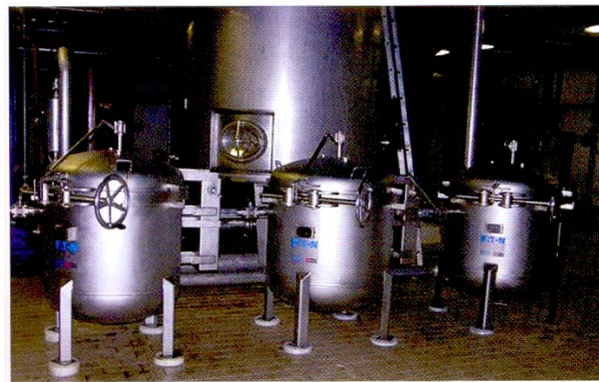
شکل ۱۳: فیلتر هایوارد برای ارتقاء کیفیت شکر سفید
