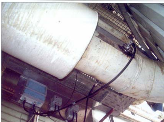
شکل ۵: سنسورهای فلات روی هر دو طرف لوله با الکترو نیکش
