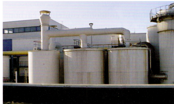
شکل ۲: واحد تصفیه شربت پس از بازسازی
