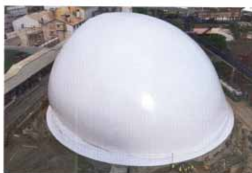
Abb. 7: Silo Kaposvár: Aufblasen der Airform
