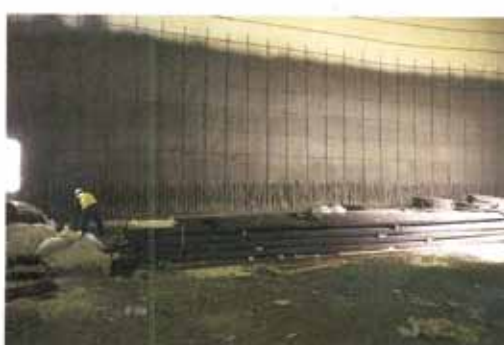
Abb. 9: Silo Kaposvár: Armierung und Spritzbeton
