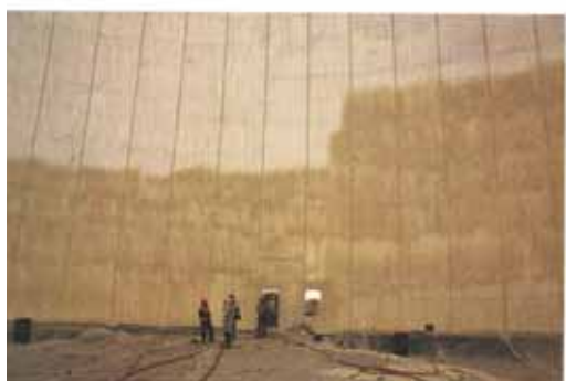
Abb. 8: Silo Kaposvár: Aufbringen der Isolierung
